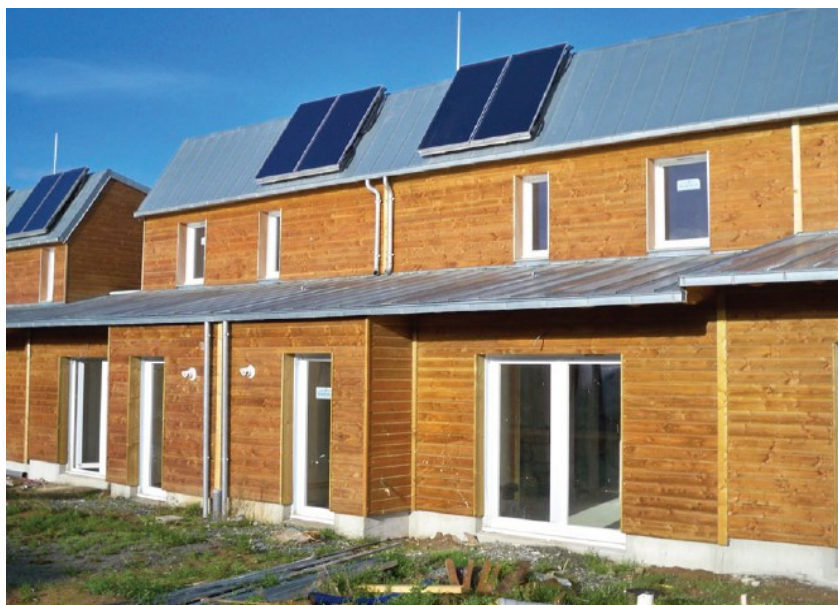
Bâtiment BBC © Thierry Jeandot
