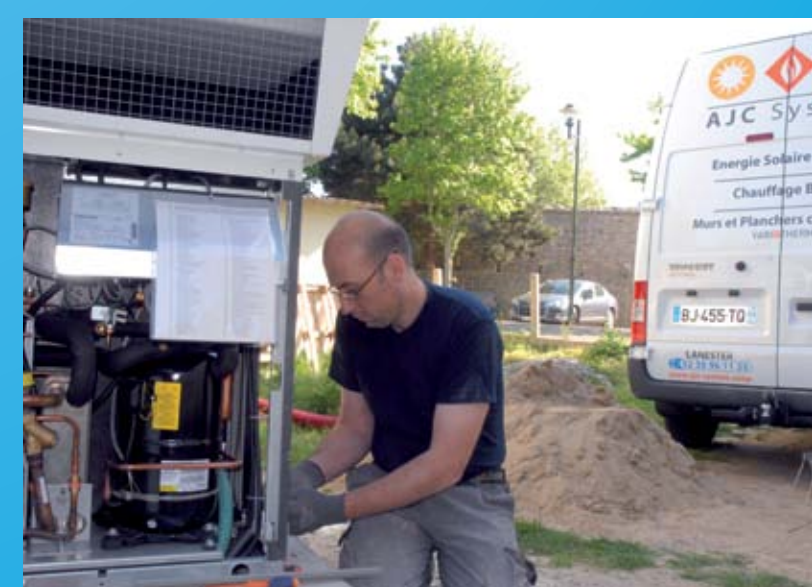
Installation d'un système de chauffage
