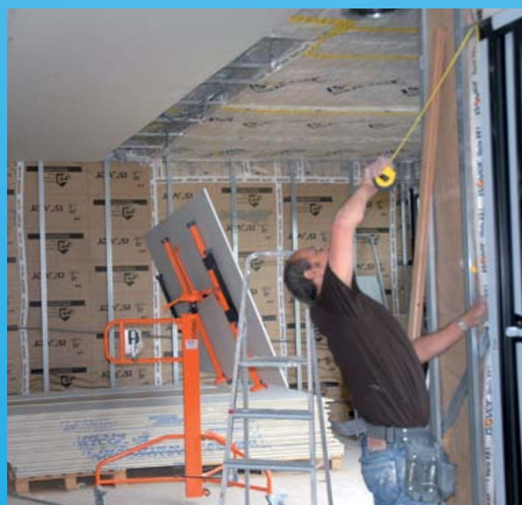
Isolation en vue de réaliser une maison passive
